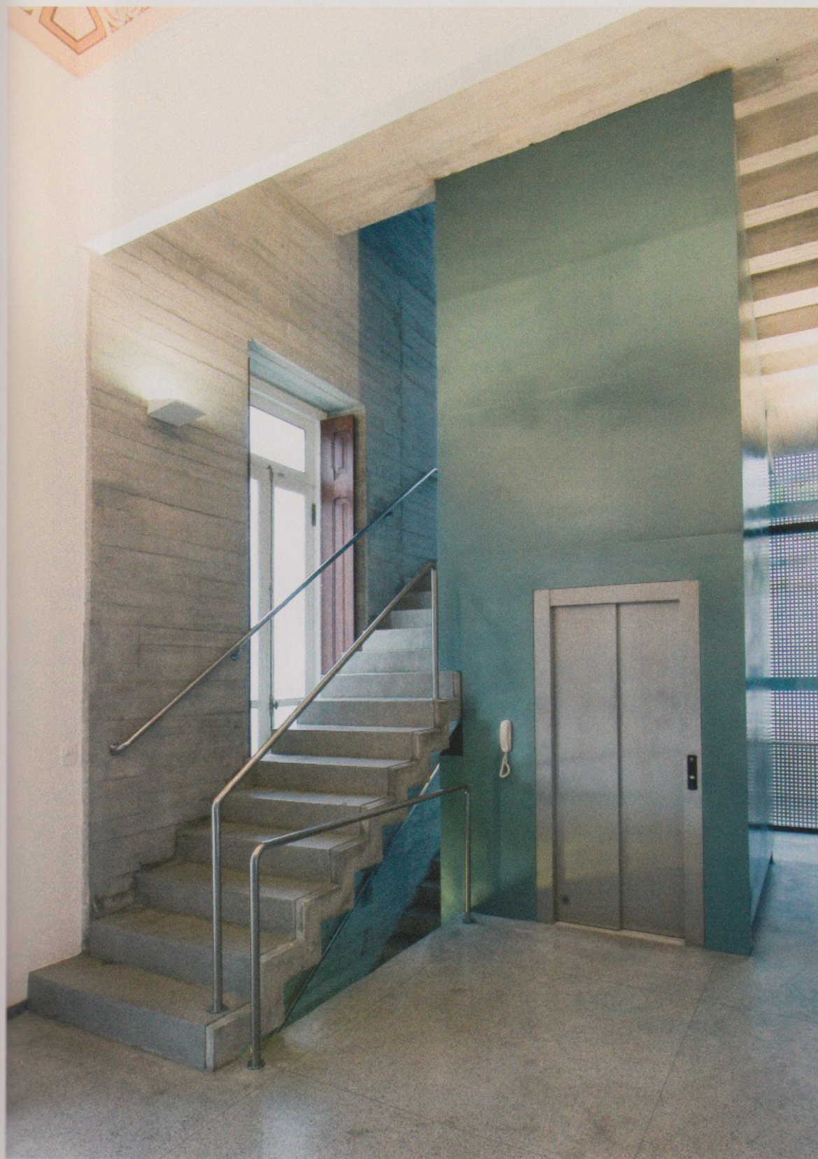
Acima, vista interna do volume de concreto acrescido ao casarão para concentrar parte da circulação vertical do museu. Na outra página, o interior do anexo. Flexível, o ambiente foi pensado para adaptar-se às exposições e permitir ao visitante que trace seus próprios trajetos
