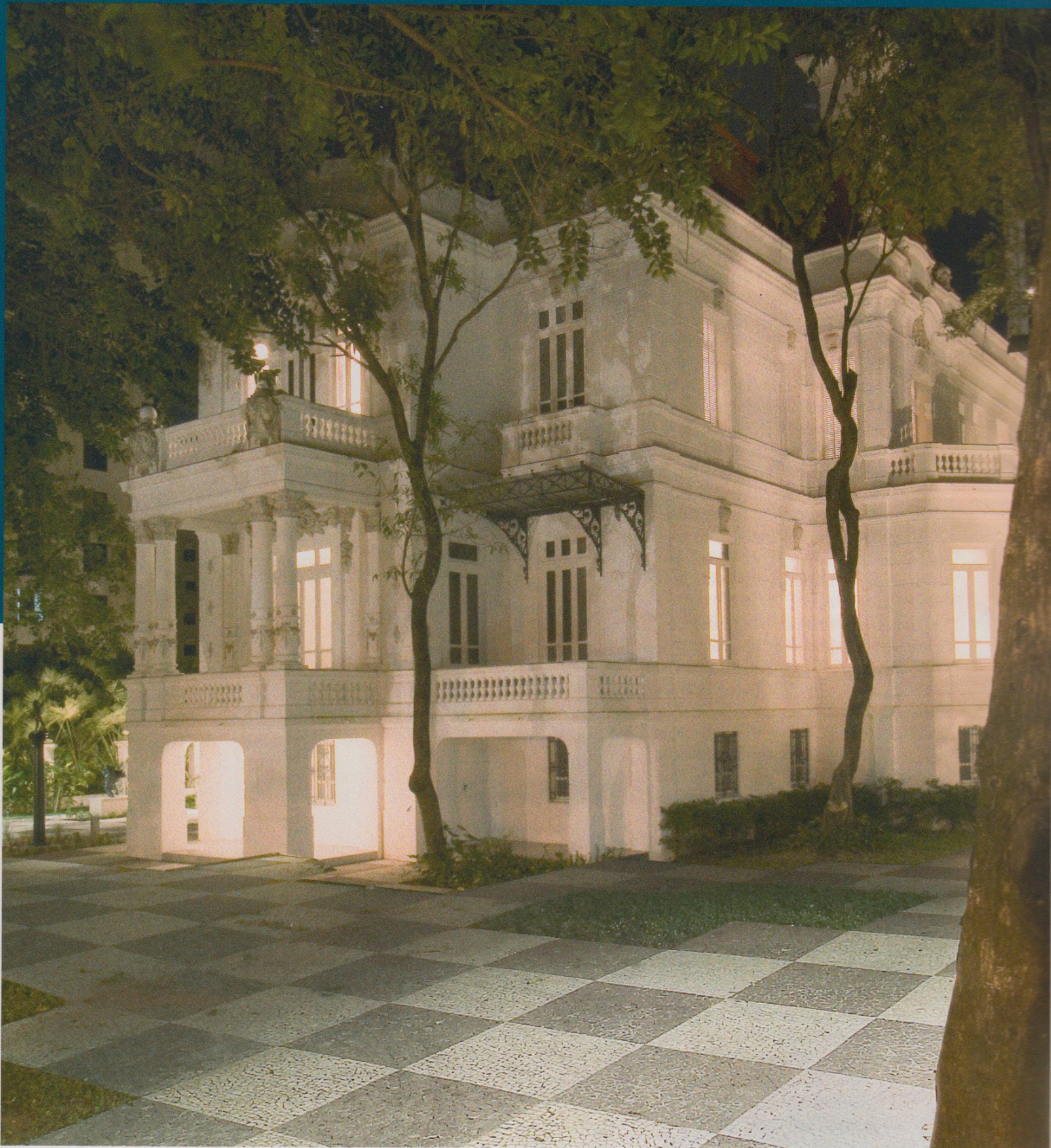
O palacete Comendador Catharino, construído entre o final do século 19 e o início do 20 em estilo eclético, foi o escolhido para abrigar o acervo destinado à filial brasileira do Museu Rodin. Na página ao lado, vista do anexo, onde serão realizadas exposições temporárias
