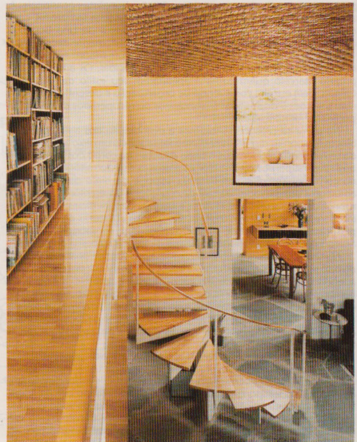
Três visões do living: a escada, um "leque autoportante"; a ponte mezanino; e a esteira de bambu trançado, que funciona como forro
