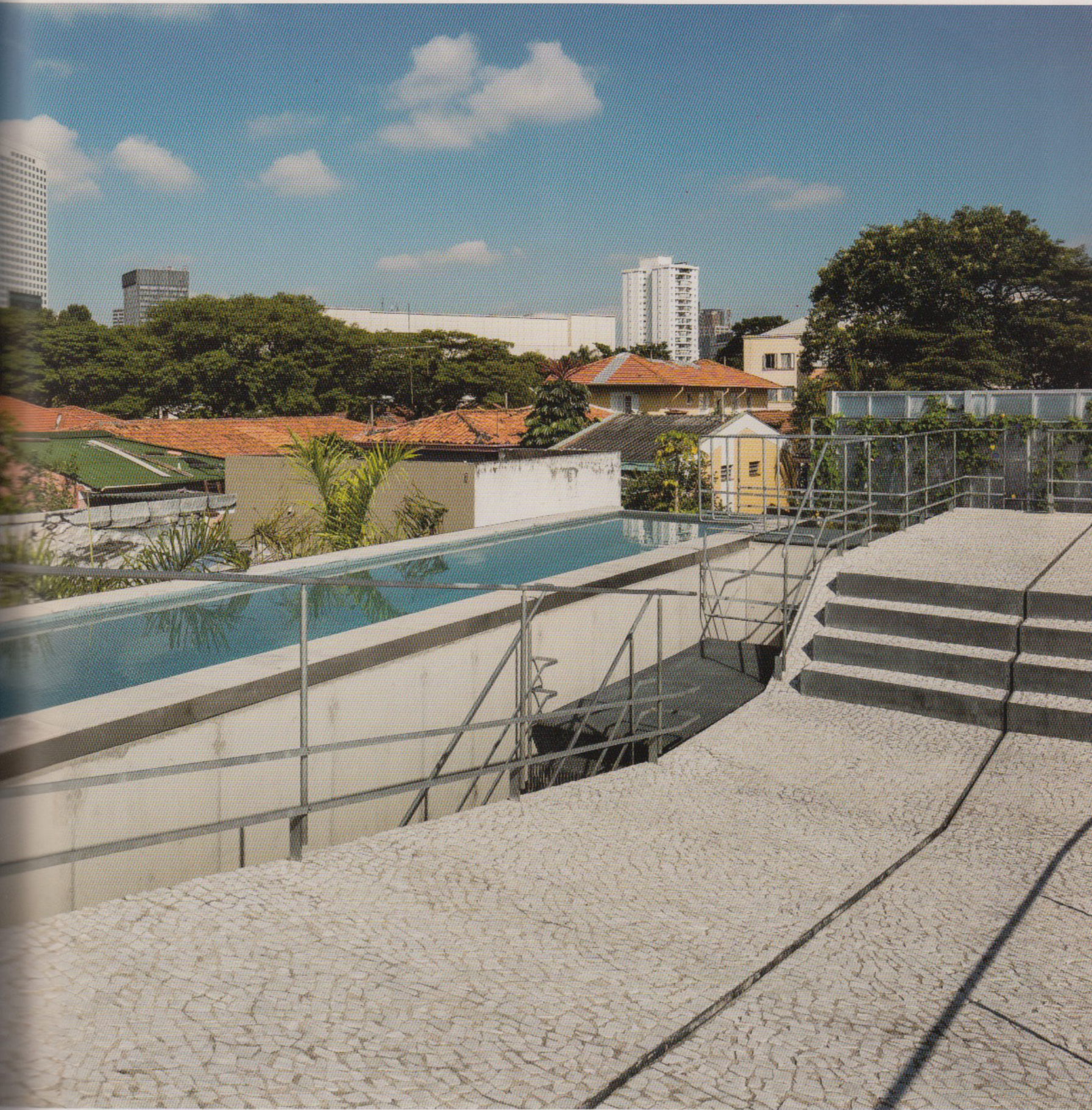
Roof terrace (solarium) with swimming pool スイミング・プールのあるルーフ・テラス (ソラリウム)
