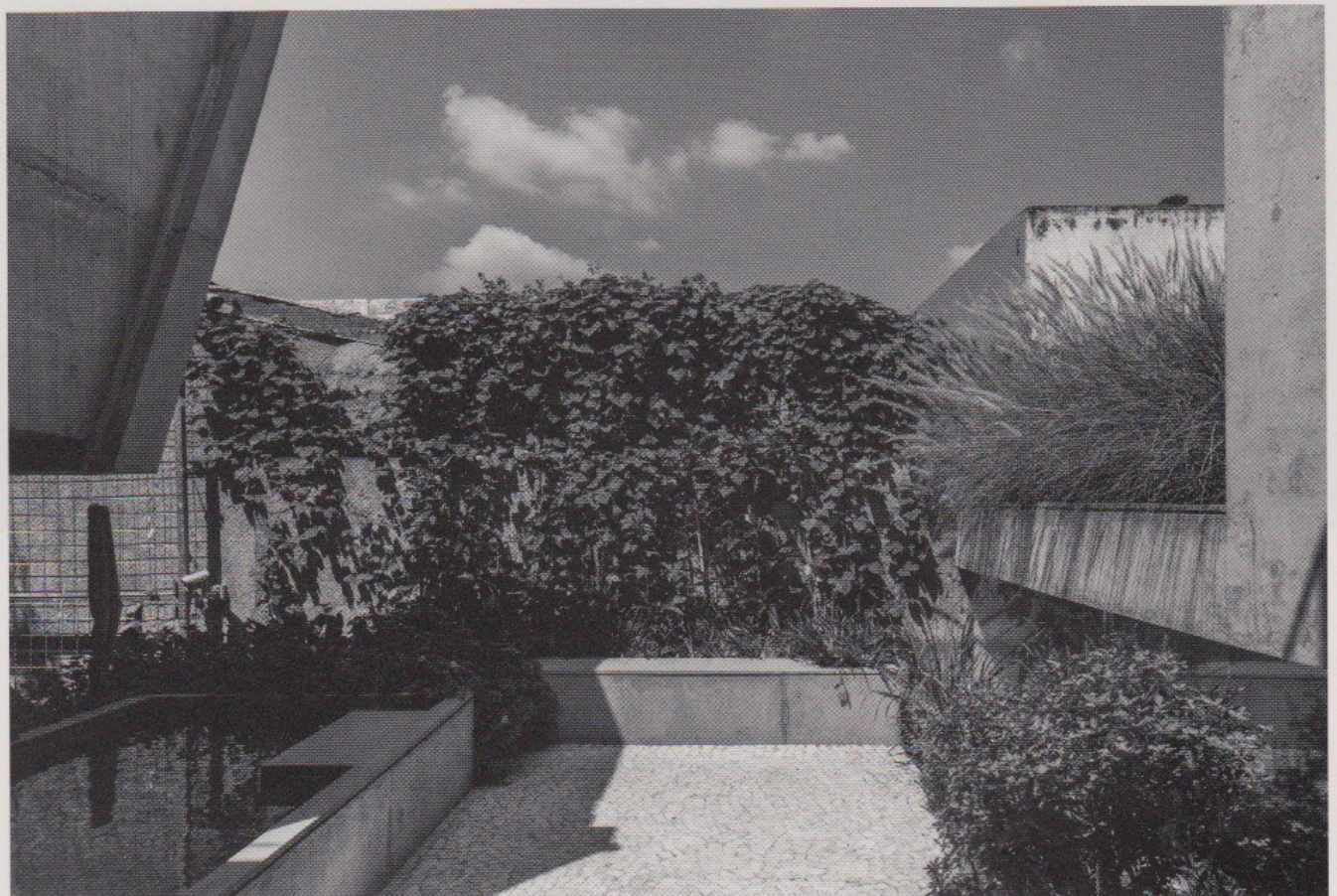
Terrace on first floor 2階テラス
