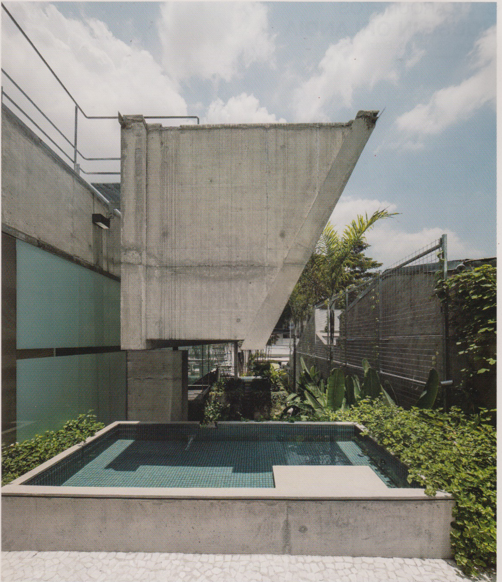
Terrace on first floor: volume of swimming pool 2階テラス：スイミング・プールのヴォリューム
