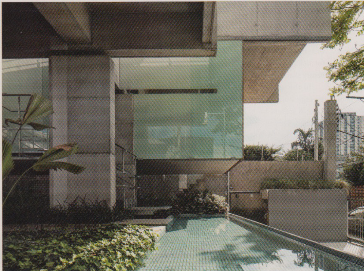
View from entry toward caretaker's room (glazed volume) 入口より管理人の部屋（ガラス張りのヴォリューム）を見る
