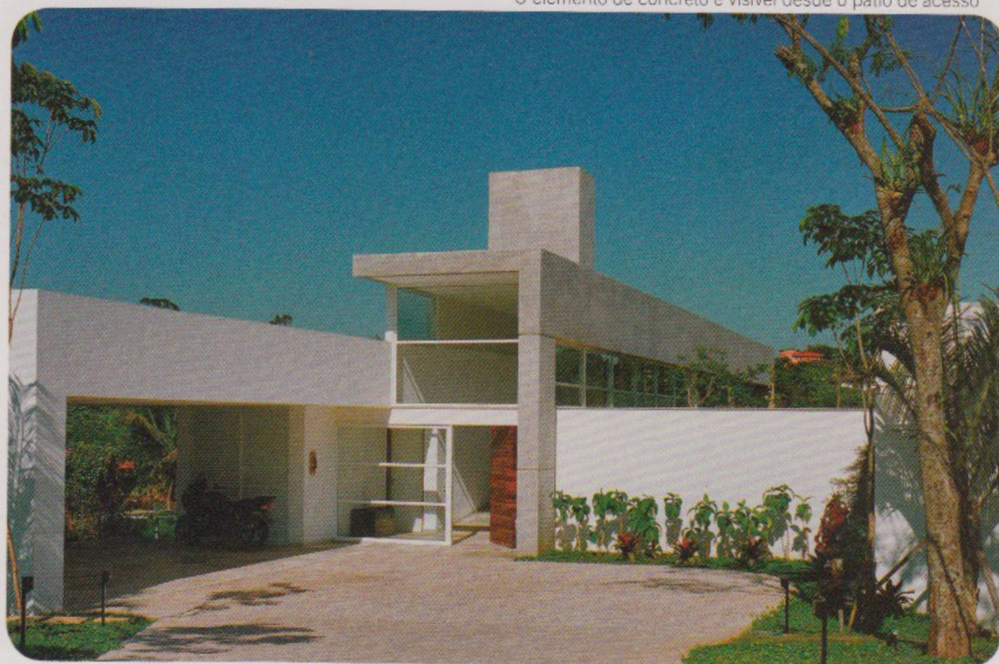
O elemento de concreto é visível desde o pátio de acesso
