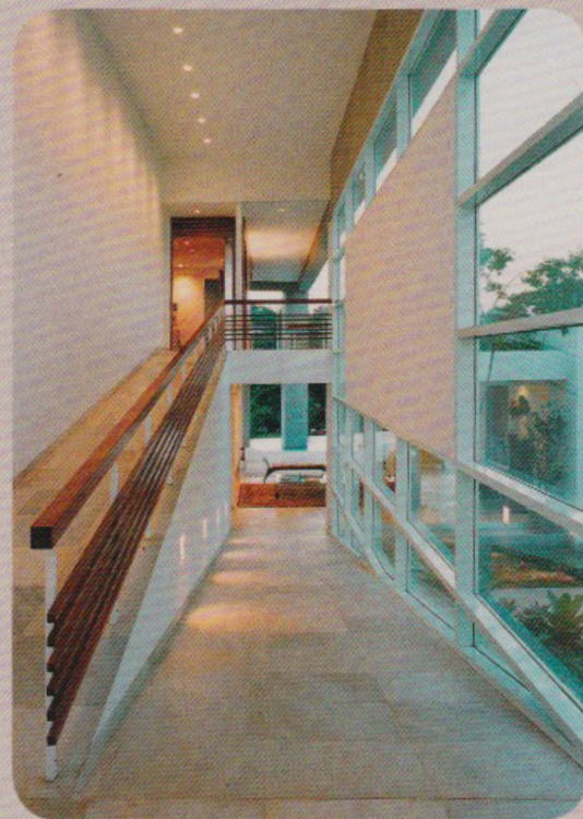
Vista das rampas, com destaque para a área fechada do caixilho: por fora, vidro branco; por dentro, placas de gesso
